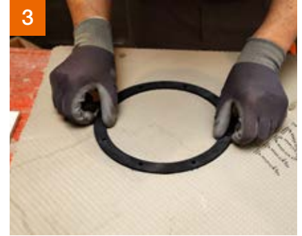
3 Eerste afdichtingsrubber met gaten erop leggen.
