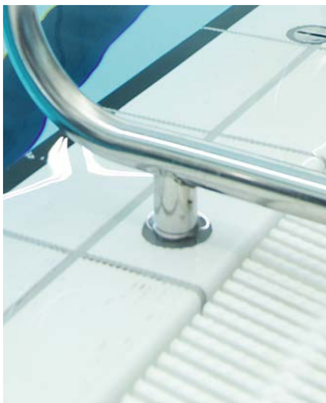
Trap met rvs-bus
