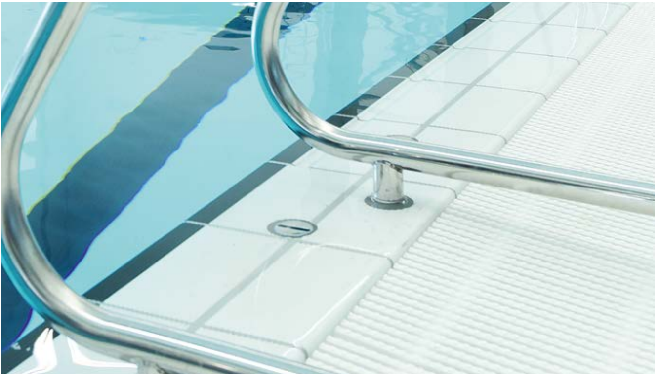
Een na de montage opnieuw afgedichte lijnkom
