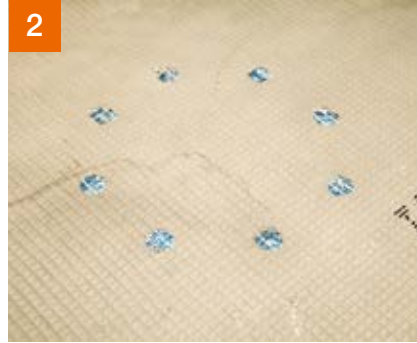
2 Van een stuk PCI Pecilastic W een sjabloon maken overeenkomstig de boorgaten in de klemflens.
