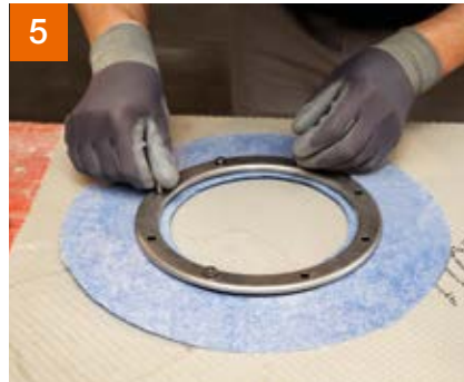
5 De schroeven plaatsen en met een stevig karton erop omdraaien.
