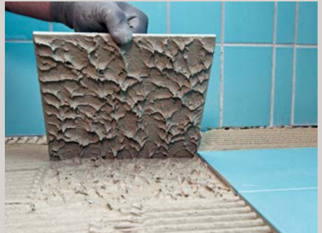
Holtevrige verlijming met de buttering-floating methode
