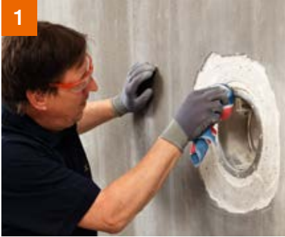
1 Eindresultaat van een klemflens met dichtmanchet.
