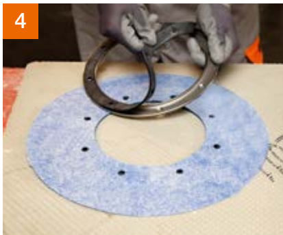
4 Met daarna het uitgesneden dichtmanchet, het tweede afdichtingsrubber en de klemflens.
