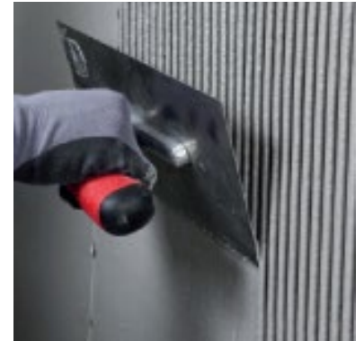
Het glad maken van de laatst aangebrachte laag zorgt voor een fijne structuur in de bovenlaag.
