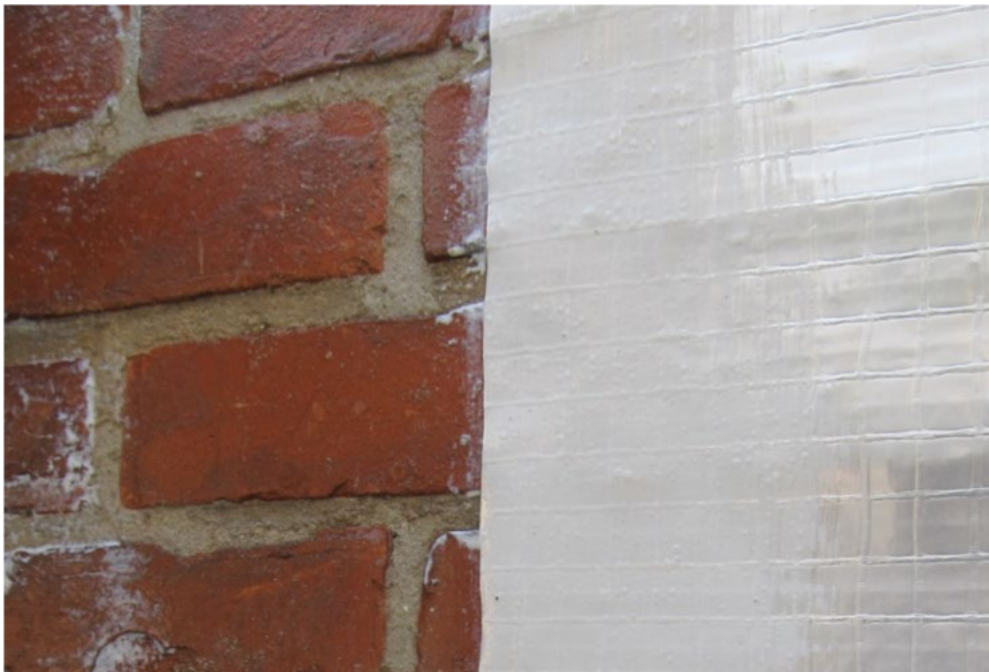
Dampscherm Reaxyl® Benfoil 31 overlappen verlijmd met Reaxyl® Foliad.
