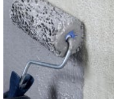
Aanbrengen van een contactlaag met een roller.
