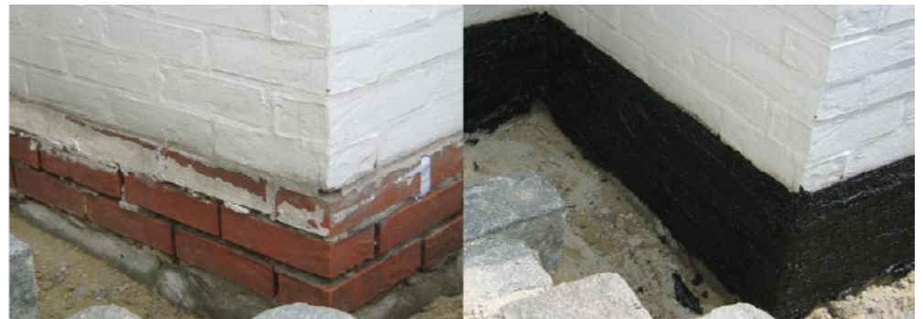
Maaivelddichting met Reaxyl® Base-X 2K
