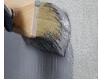
Aanbrengen van een contactlaag met borstel of kwast.
