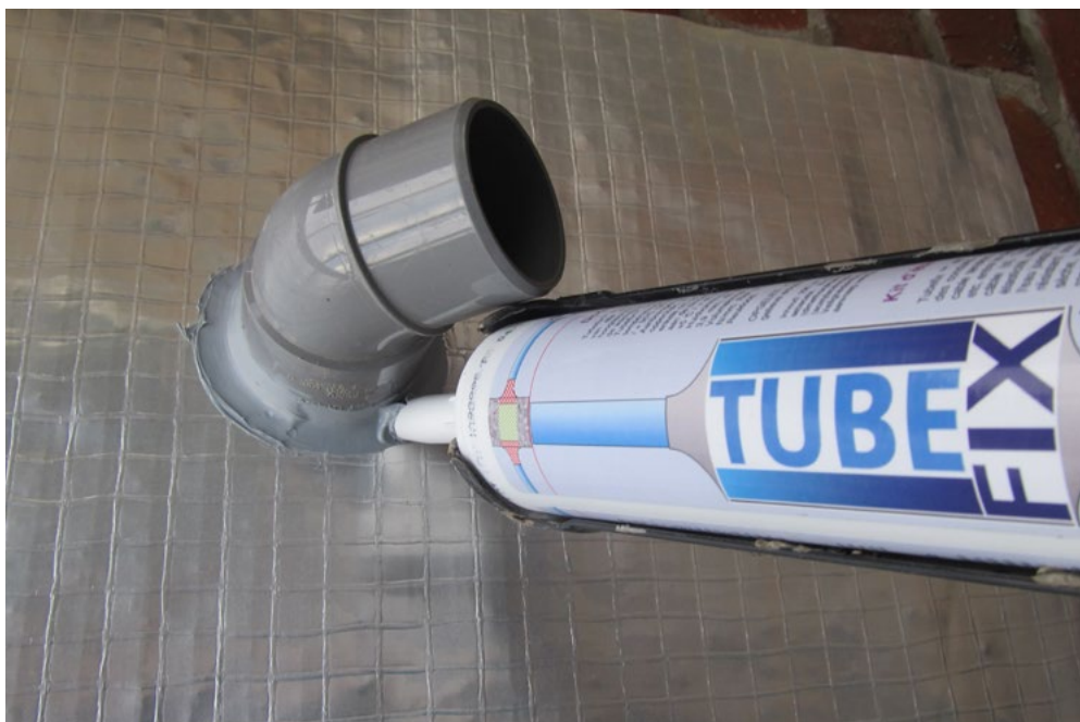
Leidingen, doorvoeren, bewegingsvoegen aansluiten met Tubefix®.
